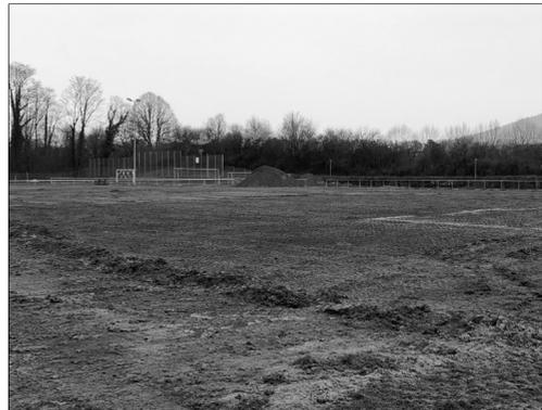
**Im zweiten Step** wird danach der Boden ausnivelliert, die sogenannte Grobplanie erstellt und somit die Grundfläche von 100x69m eingeebnet. Anschließend soll dann die Drainage und neue Beregnungsanlage eingebracht werden. **Im vierten und letzten Step** erfolgt die Feinplanie, mit anschließendem einbringen der 5 Sorten Grassaat.
