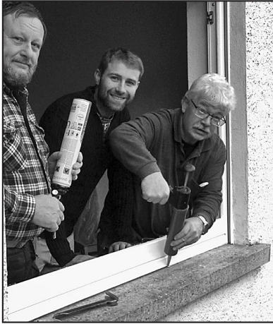
Bild: Renova-Team beim Fenstereinbau bei Capitano J. Schröder
