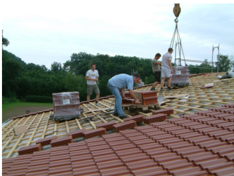
Das Dach wird eingedeckt.
