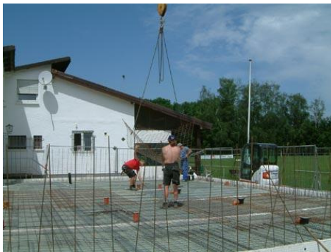
Arbeiten am Fundament.
