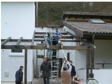
Das Vordach wird aufgeschlagen.
