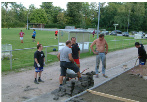
Pflasterarbeiten vor dem Clubhaus.
