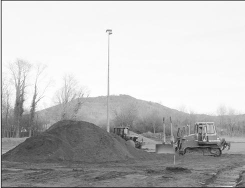
**Bild oben:** Noch steht der alte Flutlichtmast. Er wird an dieser Stelle ersetzt und ist einer von vier Masten welche die neue LED Flutlichtanlage aufnimmt.
