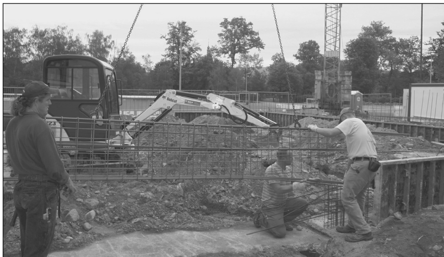
Die Arbeiten am neuen Clubhaus laufen auf Hochtouren - Mitte Juli soll bereits der Rohbau stehen.
