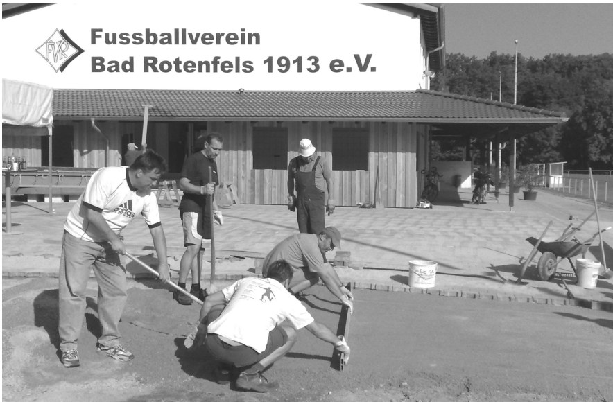
Arbeitseinsatz vor dem Clubhausneubau: Die von Lidl und Blumen-Kamm gestellten H-Steine werden verlegt.
