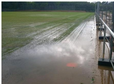
**Starkregen in der Bauphase für Entmischung der Fertigrasentragschicht verantwortlich.**
