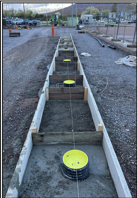
Herstellung der Köcherfundamente für Banden und Ballfangzaun.
